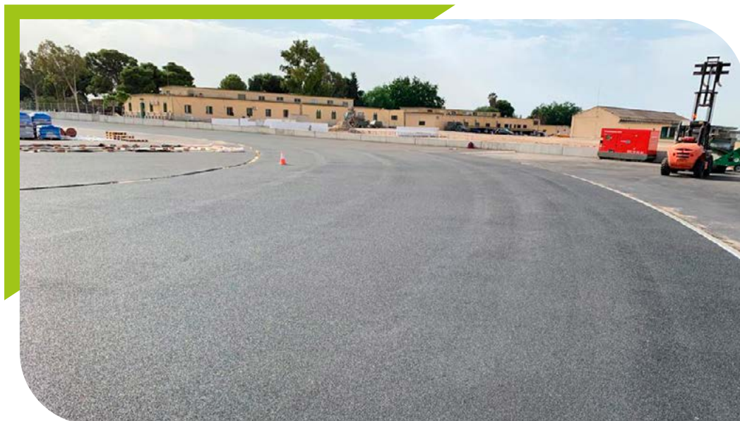
Base elástica de una pista de atletismo. Fuente: VALORIZA NEO
